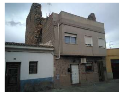
Vivienda construida en el interior de la Torre. Plaza del Castell nº2
